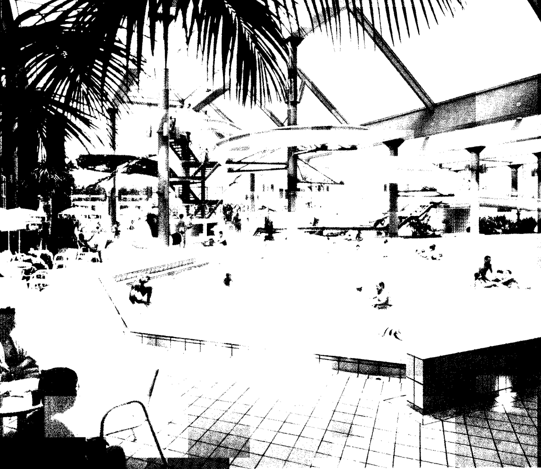
Общий вид большого бассейна, оборудованного агрегатом типа DanX
